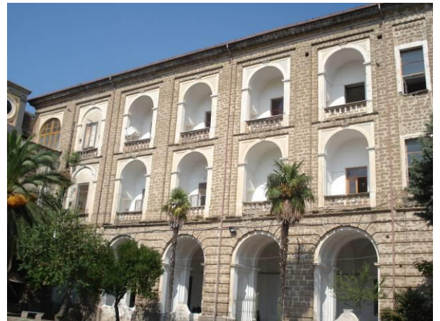
La facciata sud
