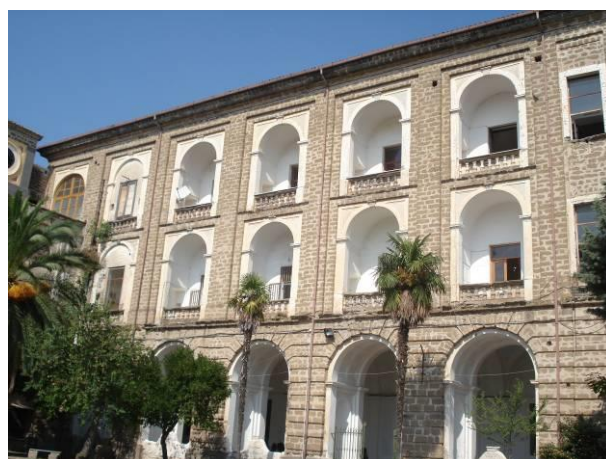
La facciata sud
