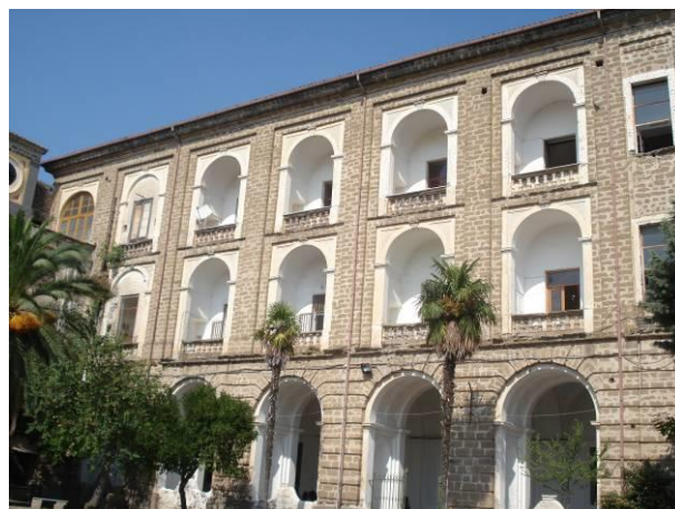
La facciata sud
