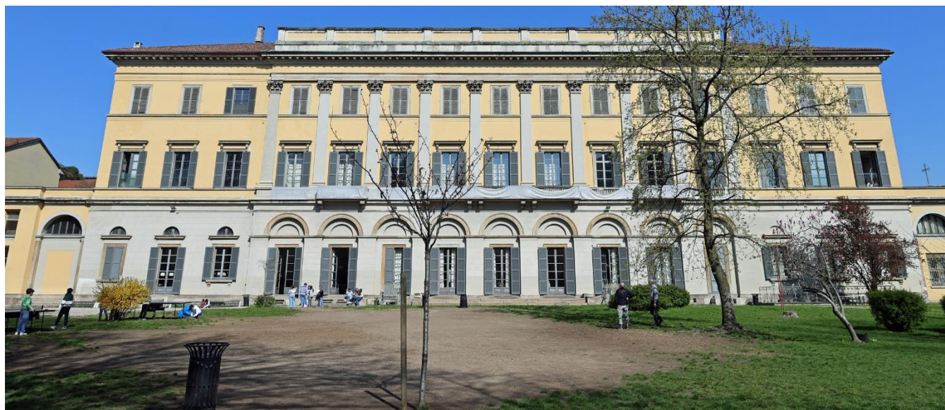
Facciata interna Palazzo Archinto n. 1
