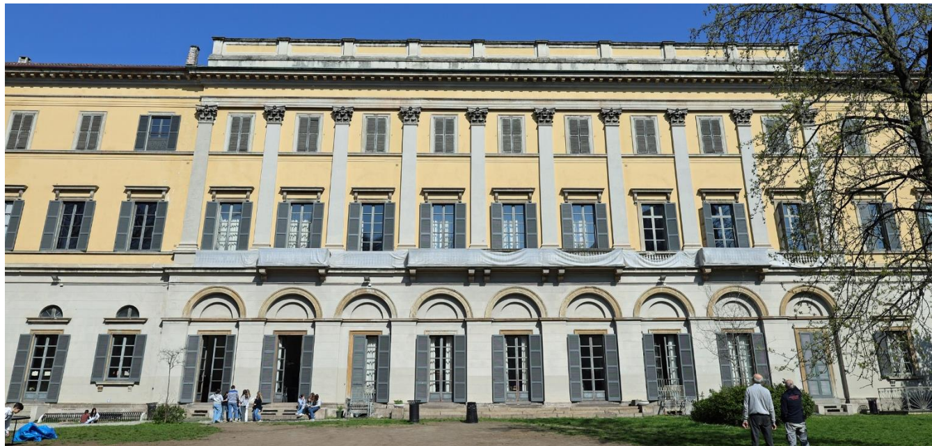
Facciata interna Palazzo Archinto n. 1
